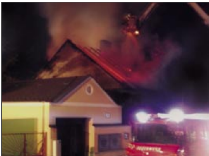
Dachstuhlbrand am 21.9. in Ulrichskirchen – dank unserer Teleskopmastbühne konnte der Brand rasch unter Kontrolle gebracht und gelöscht werden.
